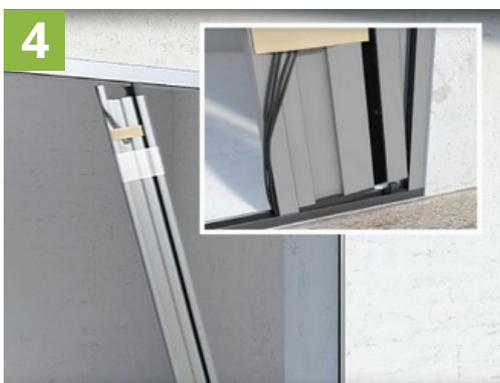
**4** Das Gewebepaket mit dem Magnetband am seitlichen Montageprofil befestigen.
