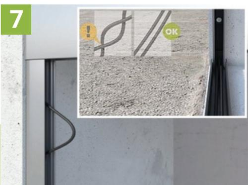
**7** Das seitliche Montageprofil mit den Schnurspannern in der Rollladenführung bzw. dem Mauerwerk verschrauben.
