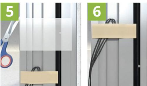
**5+6** Den Klebestreifen des Gewebepakets durchtrennen. Im Anschluss den Klebestreifen entfernen, der die Spannschnüre festhält. Darauf achten, dass die Spannschnüre nicht beschädigt werden!
